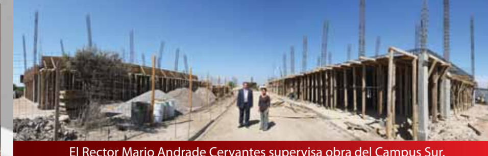
El Rector Mario Andrade Cervantes supervisa obra del Campus Sur.
