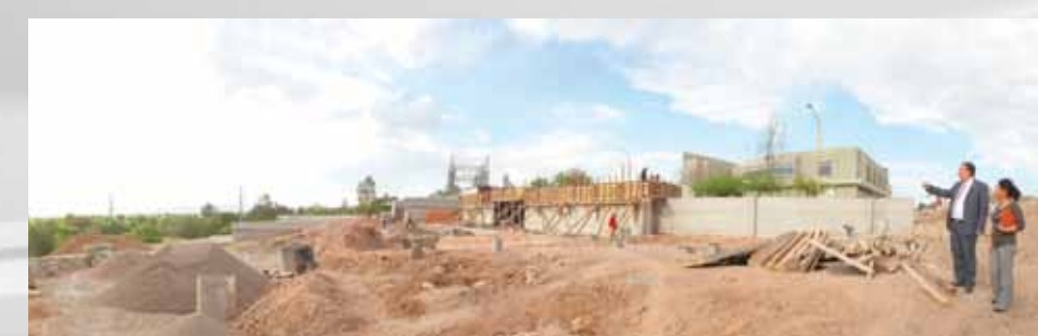
Gimnasio universitario en construcción.
