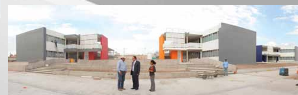
Importantes avances de obra en el Campus Oriente del CEM.
