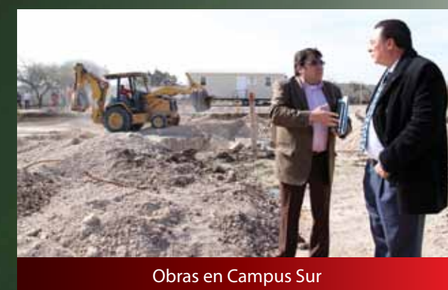
Obras en Campus Sur
