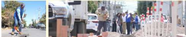
Los trabajos consisten en la rehabilitación de 30 metros lineales de red de alcantarillado con tubería de 18 pulgadas de diámetro
