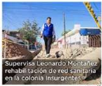
Supervisa Leonardo Montañez rehabilitación de red sanitaria en la colonia Insurgentes
