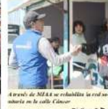
A través de MIAA se rehabilita la red sanitaria en la calle Calles
