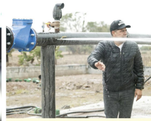
La obra requirió una inversión de 17.5 millones de pesos en perforación, equipamiento y red de distribución
